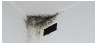
Gammel fugtskade i 2012
