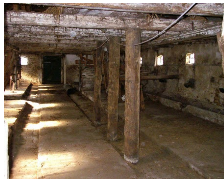
26. Råd og insektskader (gl. indretning med uens gulve)
