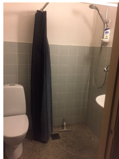
Vedr. højde på fliser ved bruser. Forudsat at væggen er udført af uorganiske materialer (tegl, beton eller letbeton) og med vådrums-maling. Ingen skade.
