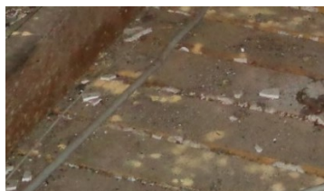
Huller med boremelet i træværk (spærtræ) (huller = 2-4 mm og runde).
